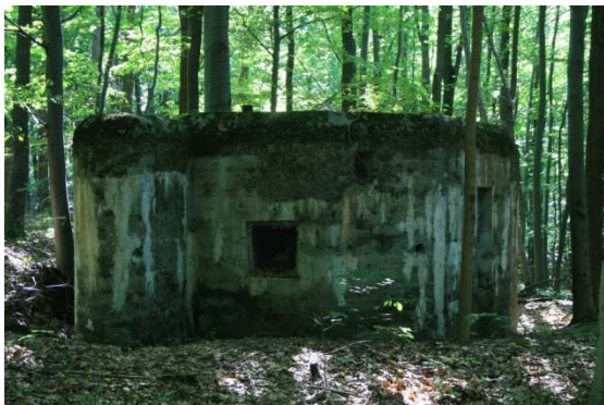
Objekt nedokončenej línie ľahkého opevnenia
