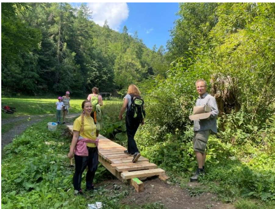
Obr. 2 Testovanie novej lávky
